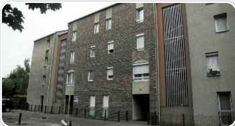
Les cages d'escalier sont aujourd'hui ouvertes sur l'extérieur
